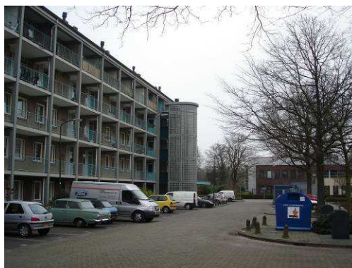
Gerenoveerde middelhoogbouw (Waterman)
