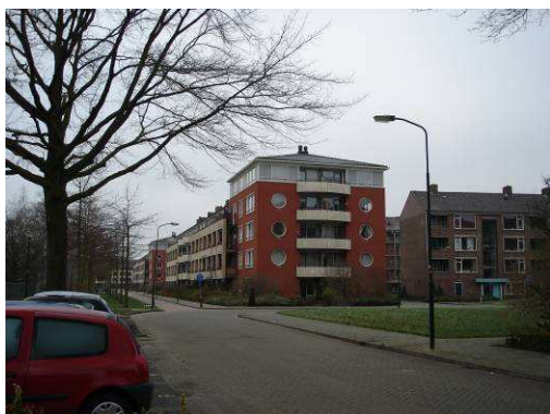
Gerenoveerde middelhoogbouw (Orionlaan)
