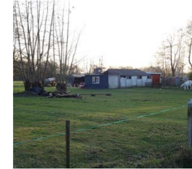
Onduidelijke opstallen en gebruik
