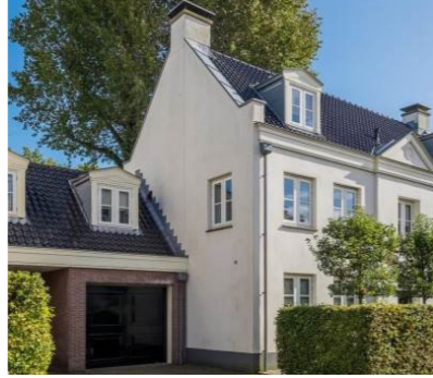
Twee-onder-één-kap woningen met aangrenzende garage
