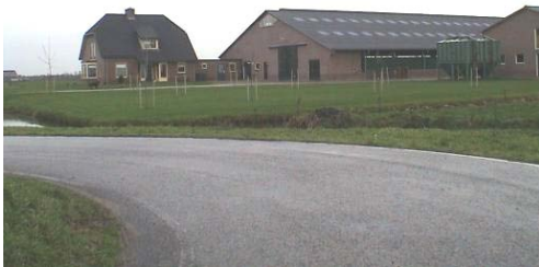
Complex met woongebouw en daarachter schuren.
