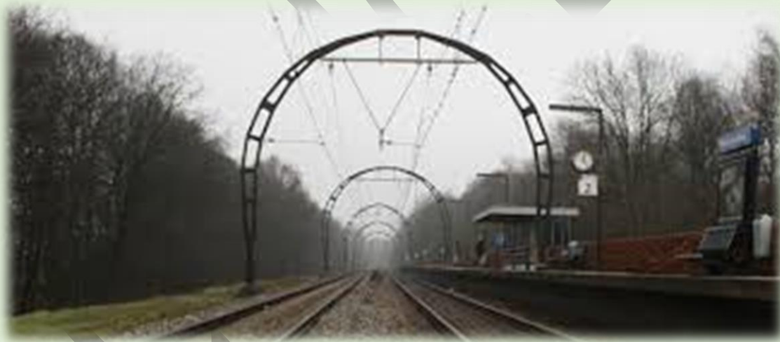
Station Hollandsche Rading: monumentale spoorlijn uit 1885 met gotische bogen voor de ophanging van bovenleidingen.
