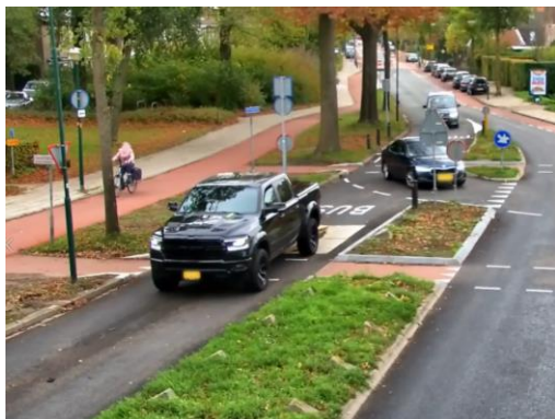
Afbeelding 56: Een automobilist met een pick-up rijdt bijna moeiteloos over de busluis heen om vervolgens via de Blauwkapelseweg de kern van De Bilt te verlaten
