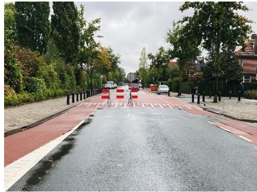
Afbeelding 49: Weghelft afgesloten middels een afzethek
